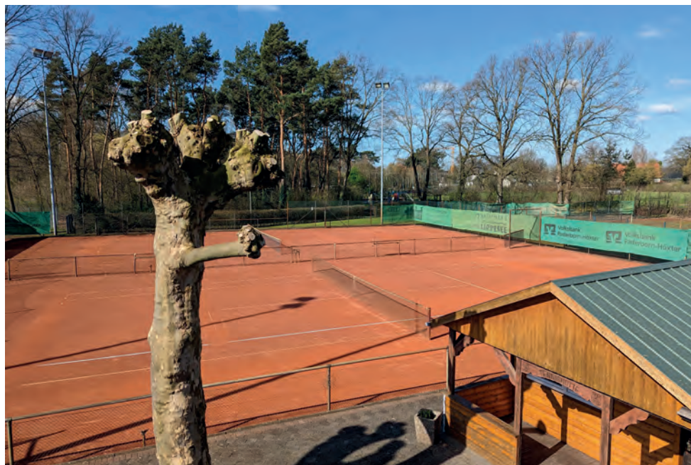
Die Anlage ist fertig gestellt
