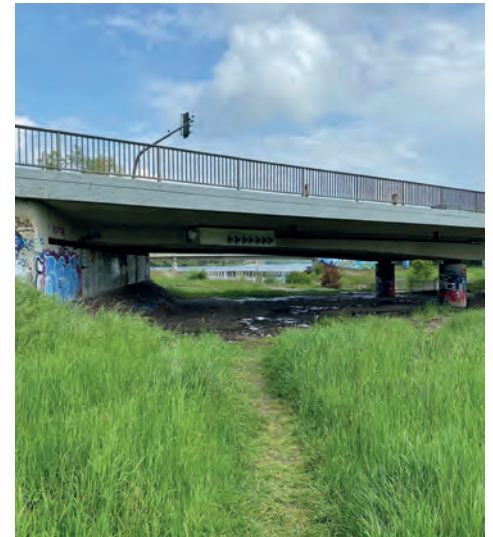
Hier soll der Radweg zukünftig die B64 unterqueren
