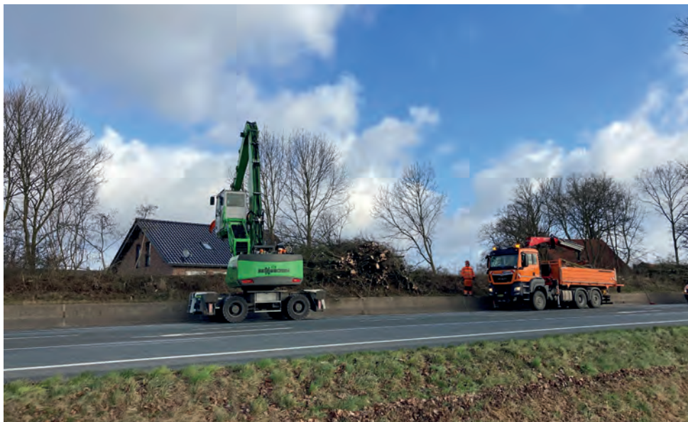
Die Rodungsarbeiten haben begonnen
