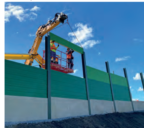
Die Aluminiumlochelemente werden eingeschoben
