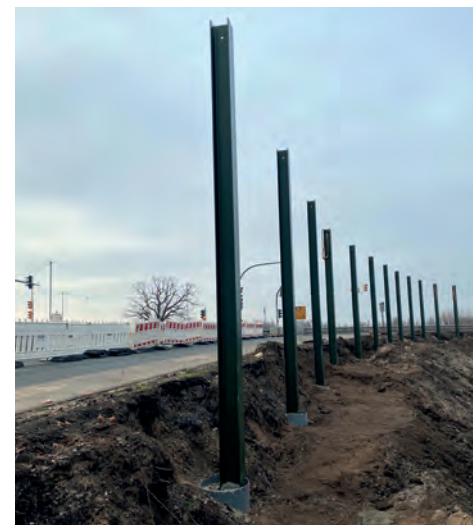
Die Stützpfiler stehen
